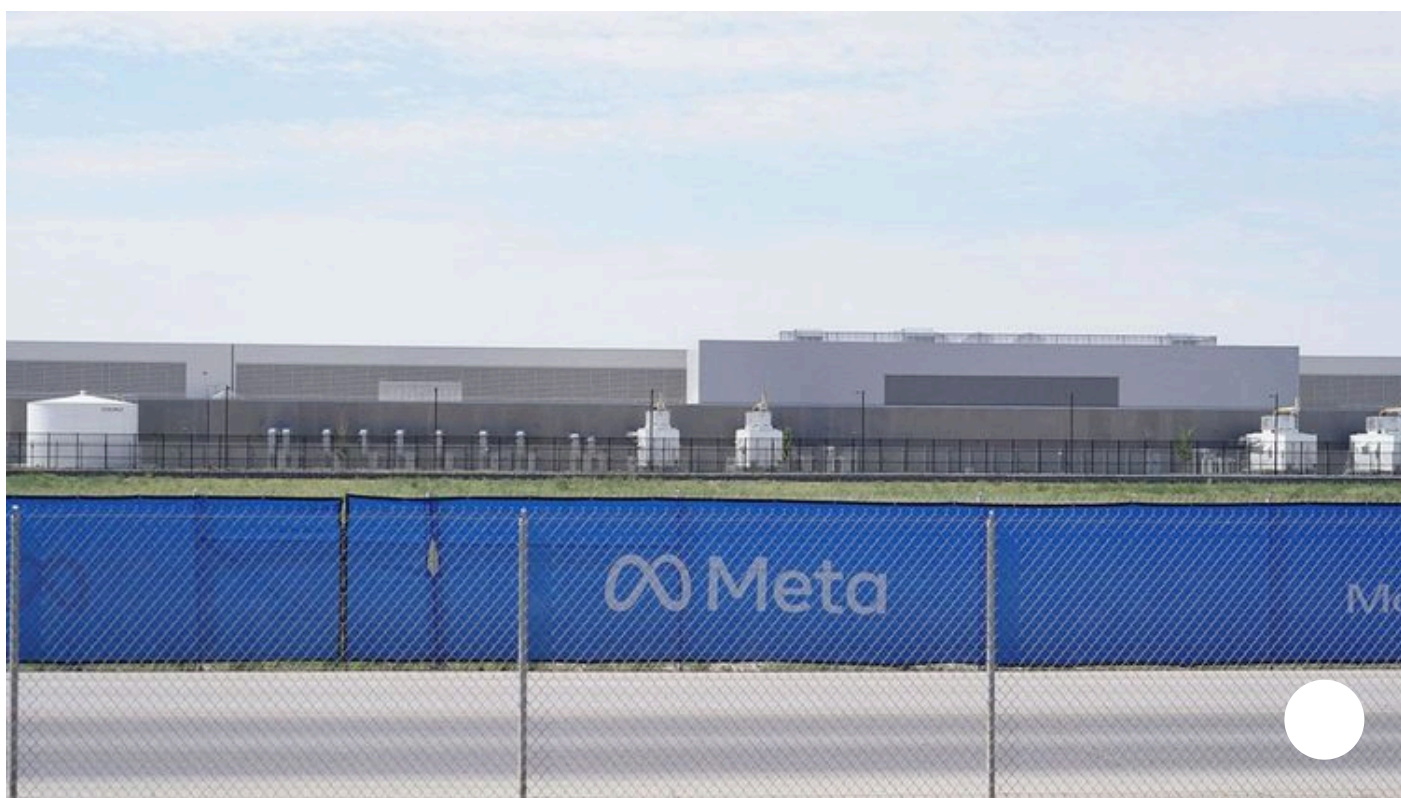
Le nouveau data center de Meta's Facebook à Eagle Mountain, dans l'Utah. Le complexe couvre une surface égale à vingt terrains de football. (GEORGE FREY/AFP)
